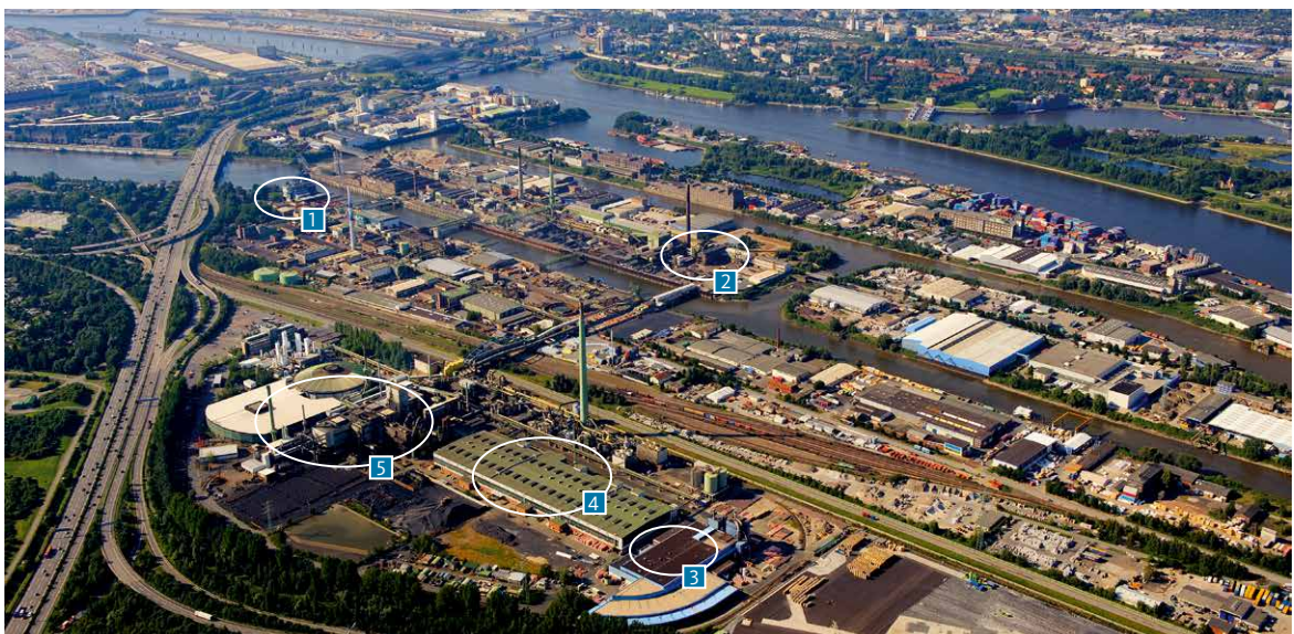
1 Stranggussanlage 2 Sekundärhütte/Edelmetalle 3 Rodanlage 4 Elektrolyse 5 Rohhütte Ost
