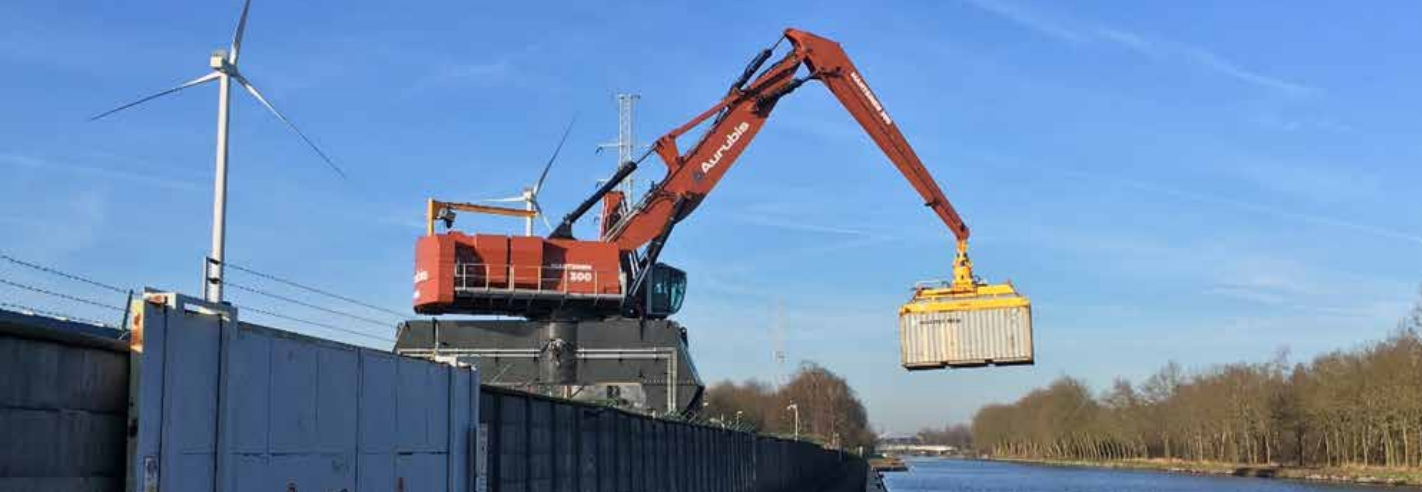
Erste Testläufe der Anlage zur Schiffsbeladung (Cu-Port) am Standort in Olen
