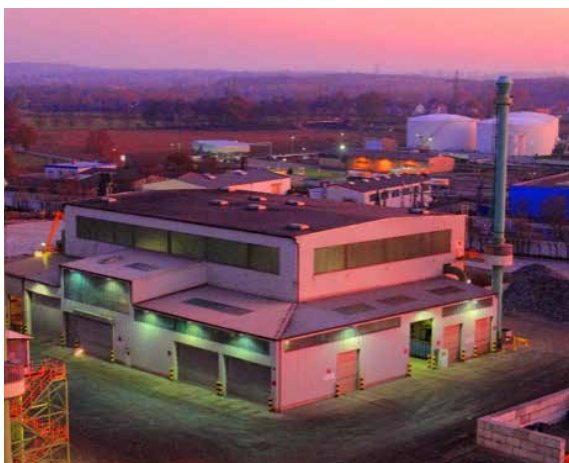
Luftbild der Anlage zur Materialvorbereitung, Zerkleinerung und Separation (MV-ZS-Anlage) in Lünen
