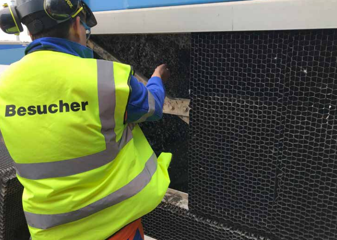
Inspektion der Verdunstungskühlanlagen durch den Sachverständigen
