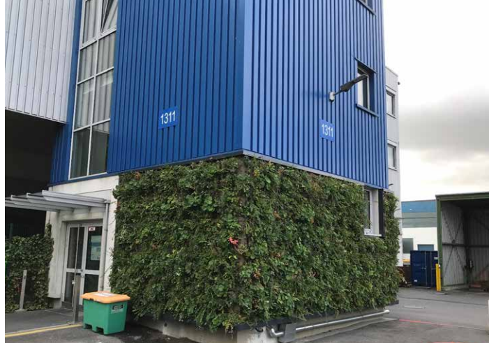
Vertikalbegrünung an einem Büro- und Produktionsgebäude im Werk
