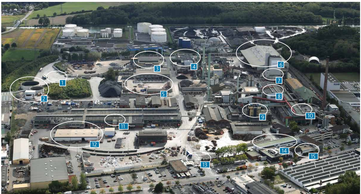
Abb. 3.1: Anlagenübersicht des Standorts Lünen
